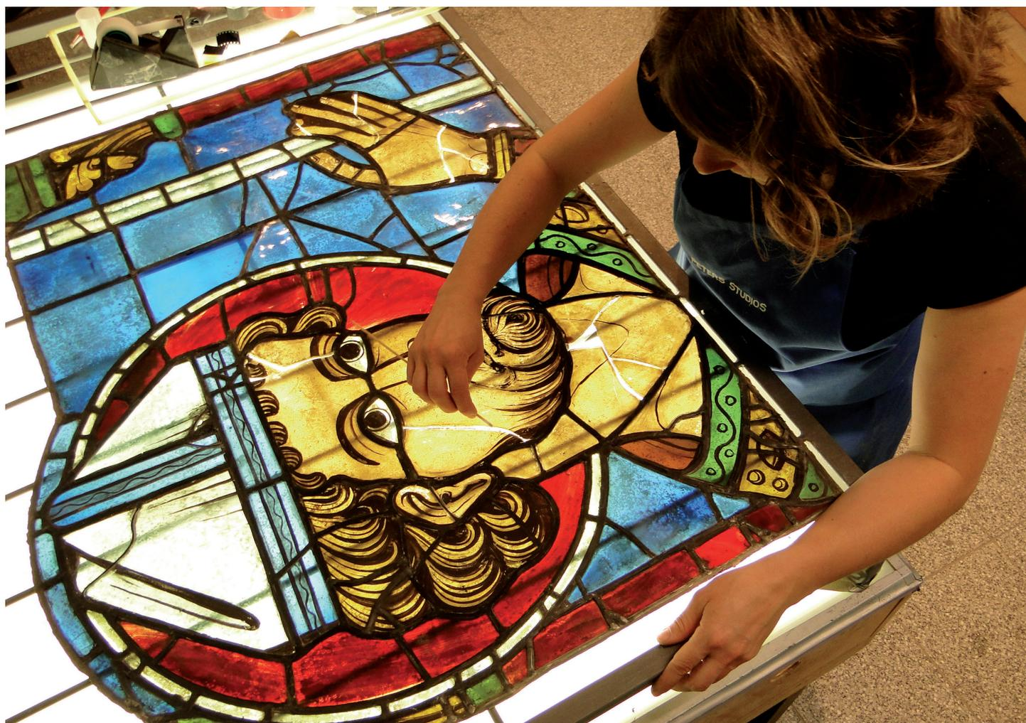
*Entfernen der Notbleie und Verklebung der Sprünge*
