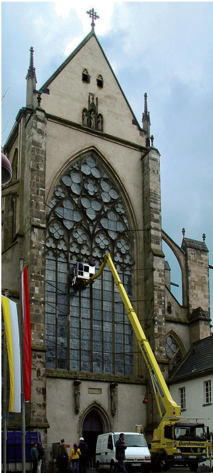
Anbringen der Glassensoren außen auf der Schutzverglasung
