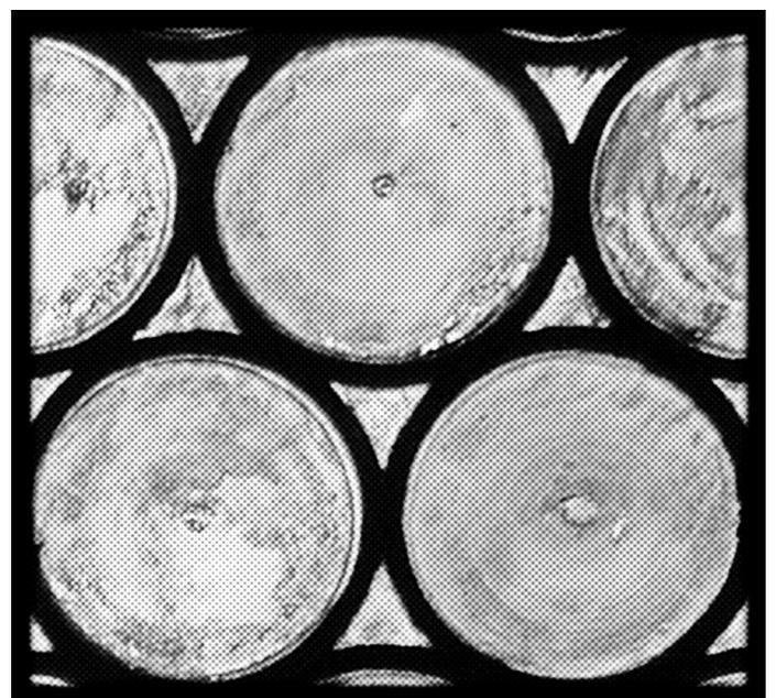
Rekonstruierte Scheibe im Siebdruckverfahren - Detail
