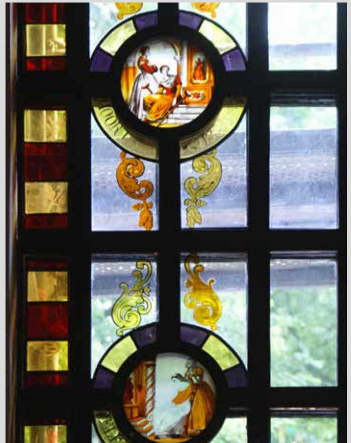
Detail van medaillonramen na behandeling. Ook de raambruggen van de medaillons werden verdubbeld zodat het originele glas beschermd is voor invloeden van buitenaf.
