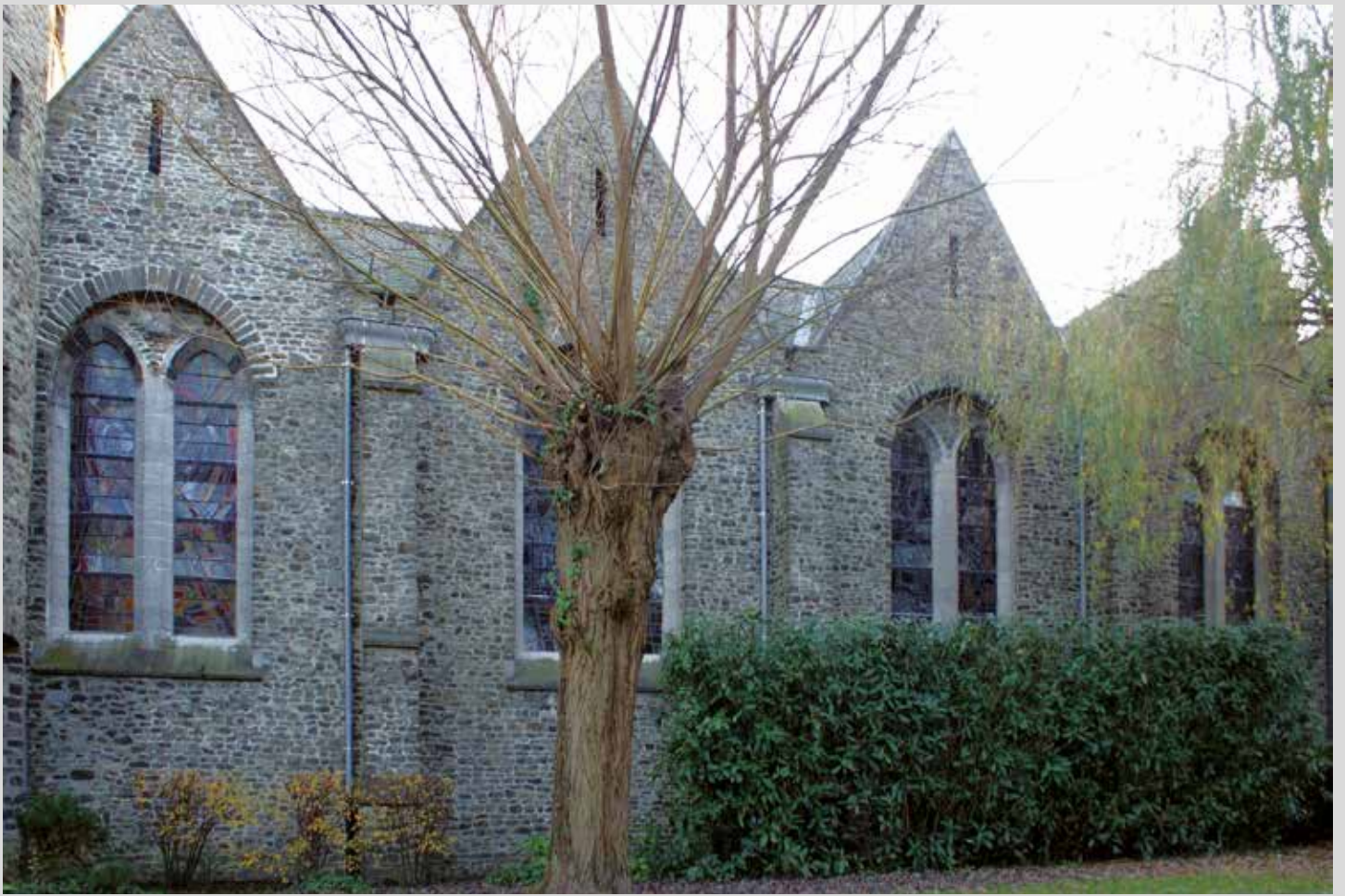
Sint-Martinuskerk: glasramen voor behandeling. Bemerkt de uitgebuite glas-in-loodpanelen
