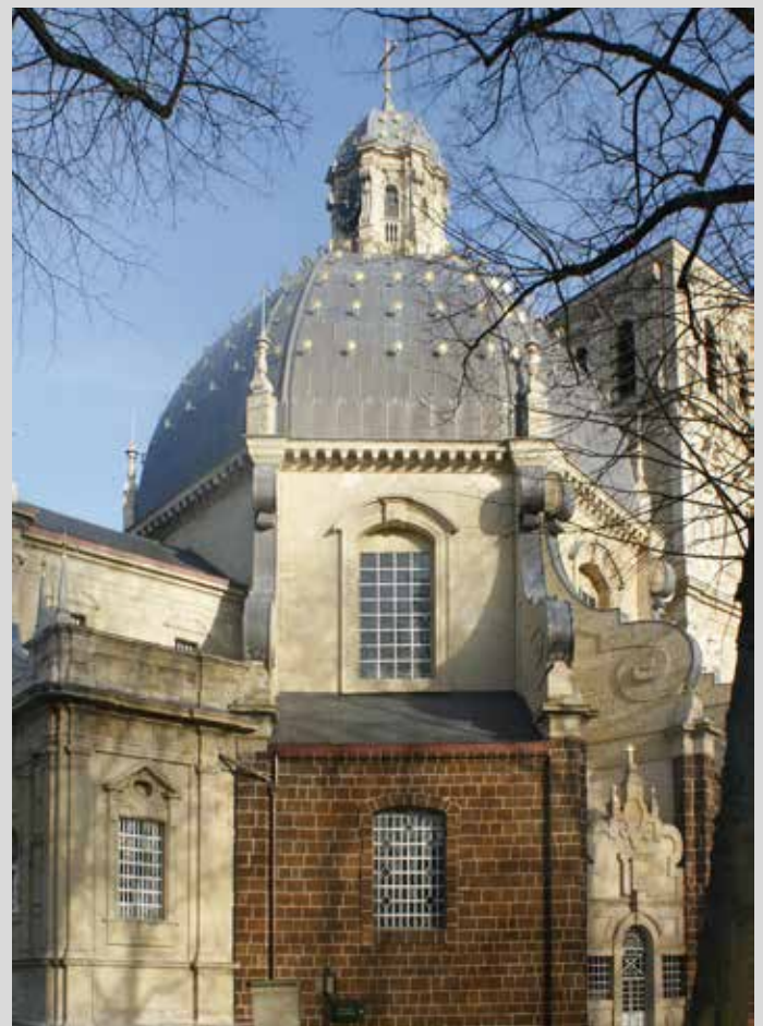
Basiliek na restauratie. Bemerkt het medaillonraam onder en het glasraam in gebruikelijk raambrug-deklatsysteem
