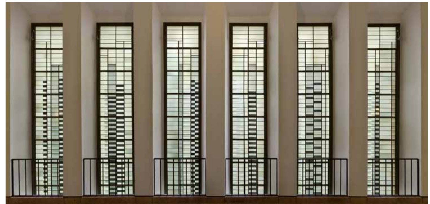
Innenansicht nach der Rekonstruktion
