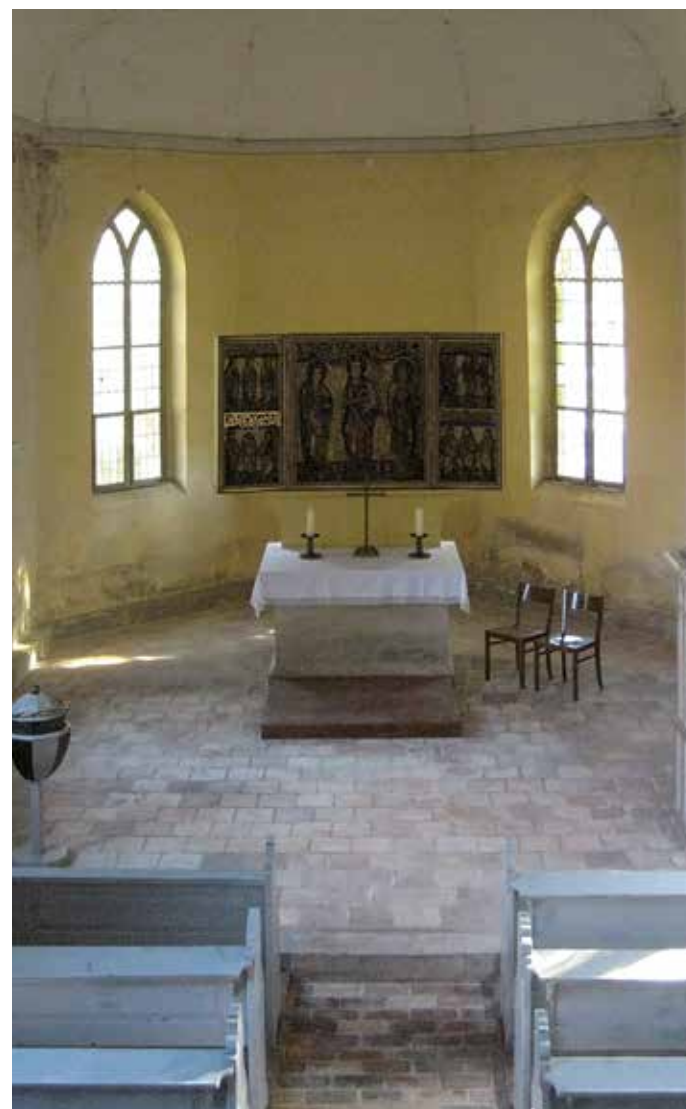
44 Vor der Maßnahme - Ev. Kirche Großbadegast 2019
