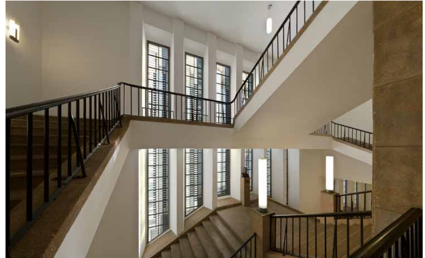
Innenansicht nach der Rekonstruktion
