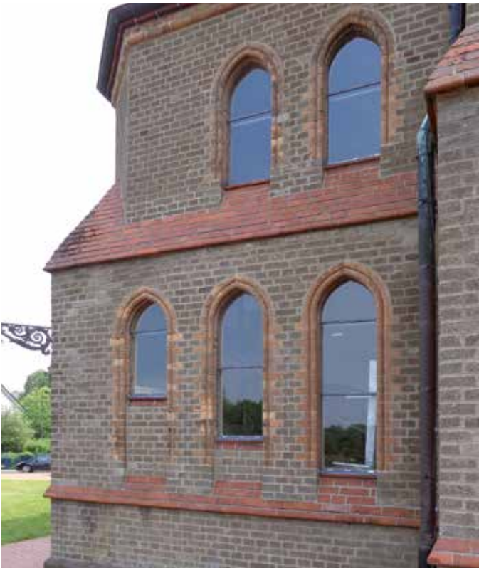
Abschluss der Gebäudehülle durch die Schutzverglasung - die Kunstverglasung wird nach der Restaurierung einfach von innen vorgesetzt.
