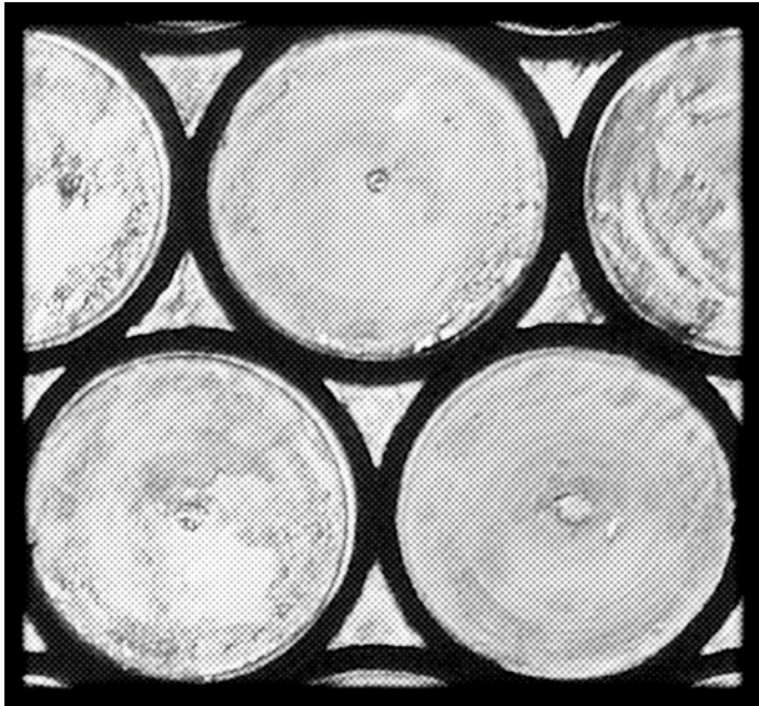
Rekonstruierte Scheibe im Siebdruckverfahren - Detail
